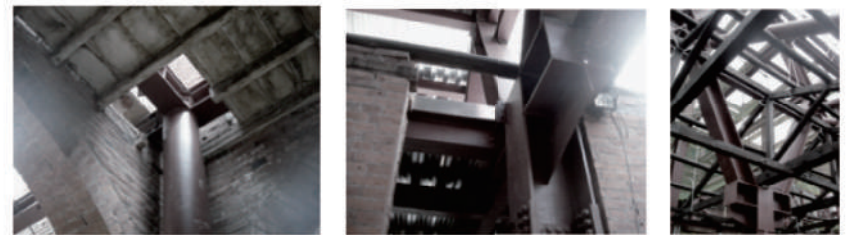
補強鋼構架與磚牆、磚柱、磚拱之關係
